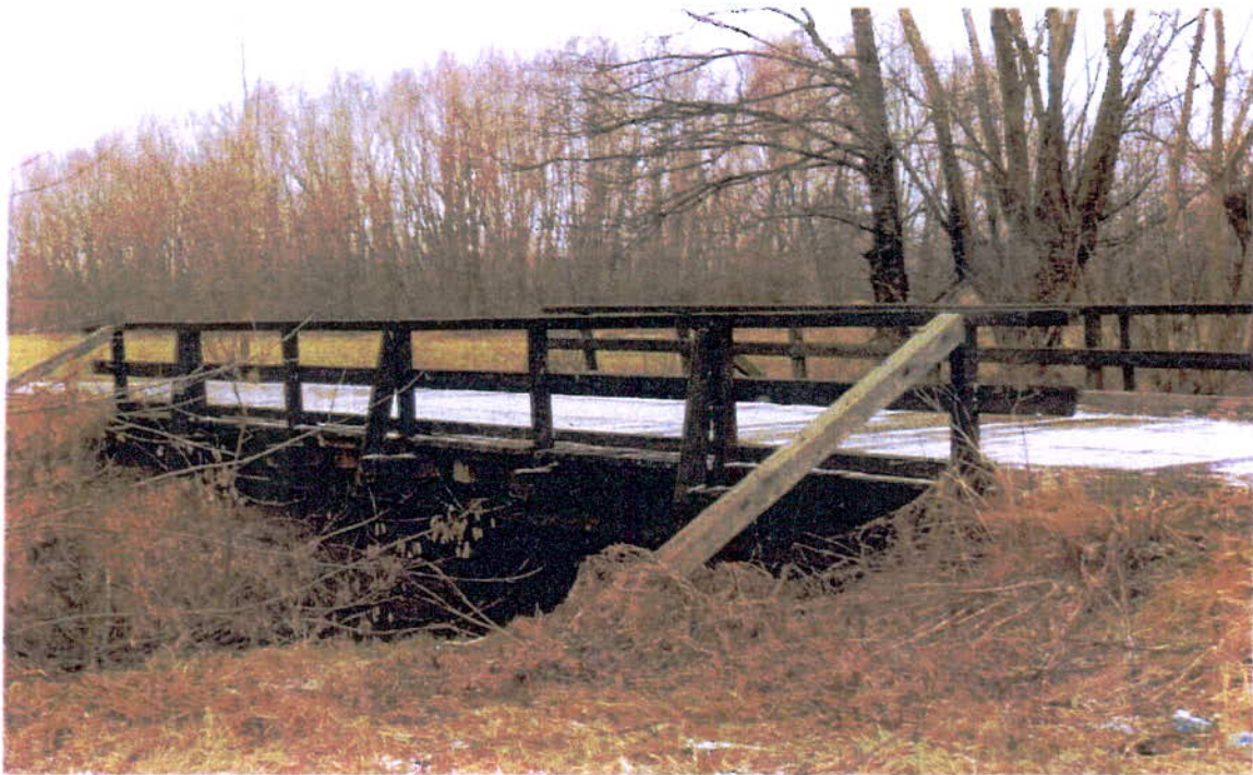
Zdjęcie 8. Most łączący Dobrocice i Pielaszów- fot. GRACZKOWSKI DOTACJE Sp. z o.o.
