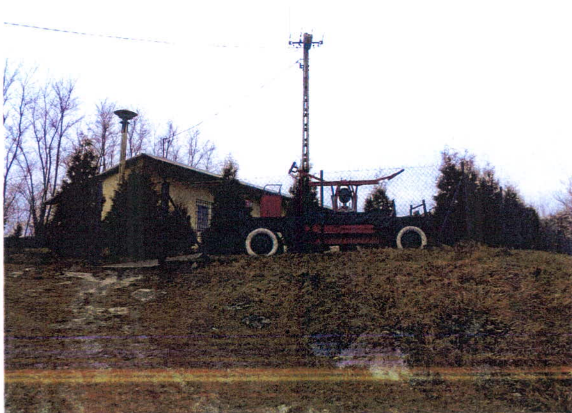
Zdjęcie 46. Budynek Ochotniczej Straży Pożarnej w Pęczynach wraz z zabytkowym wozem strażackim- fot. GRACZKOWSKI DOTACJE Sp. z o.o.
