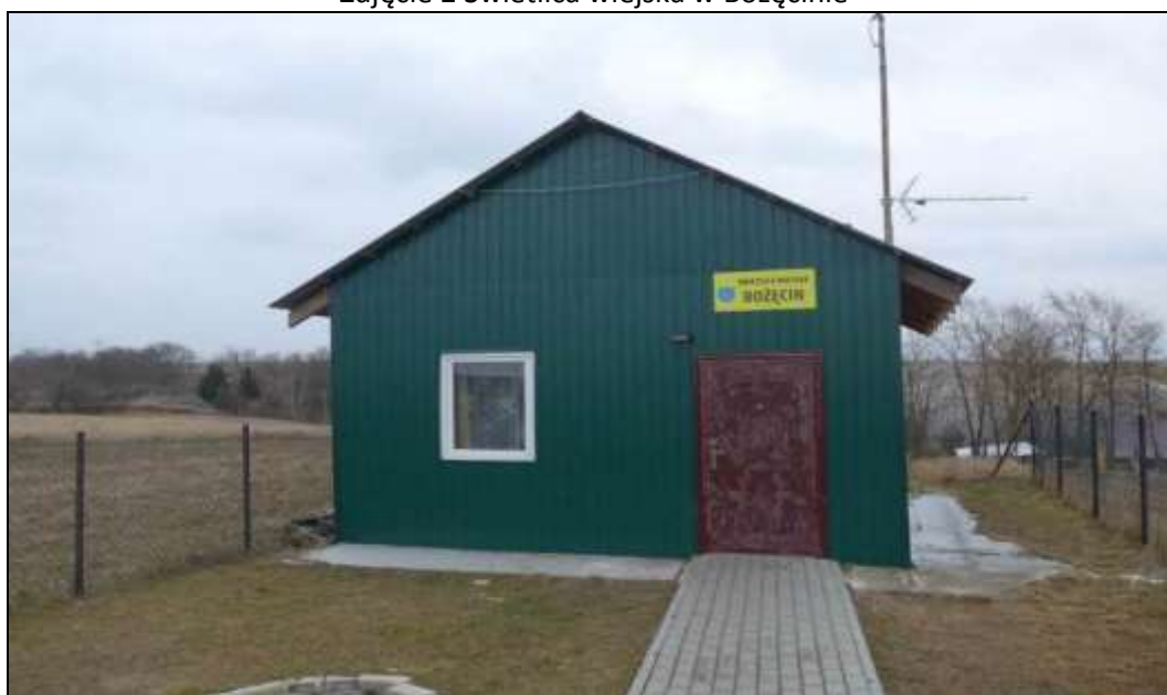
Zdjęcie 2 Świetlica wiejska w Bożęcynie
