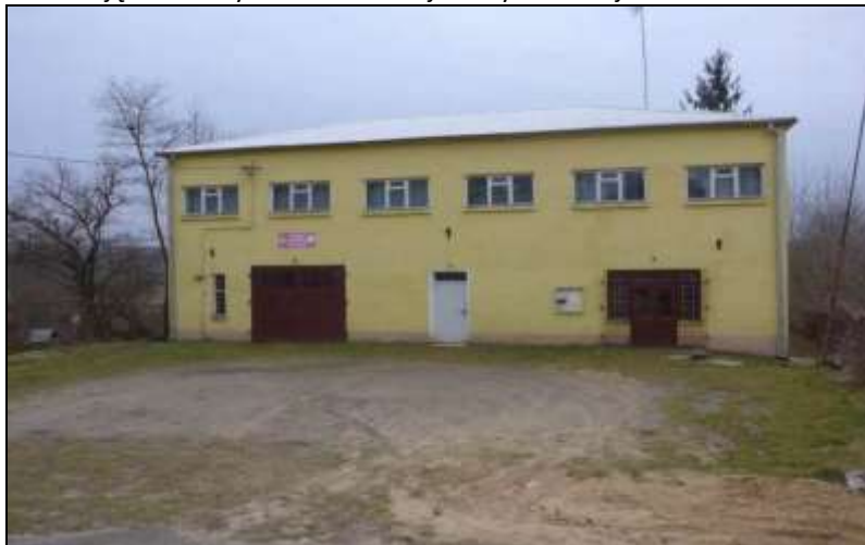
Zdjęcie 6 Budynek Ochotniczej Straży Pożarnej w Tułkowicach
