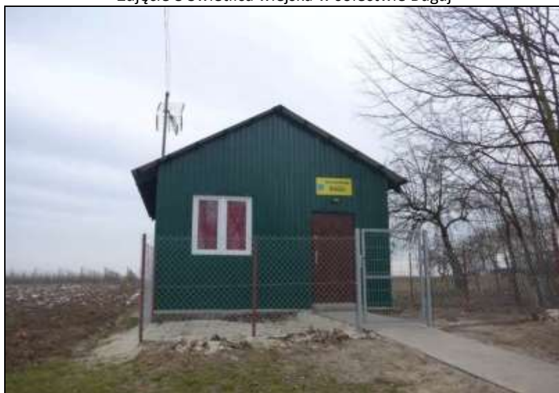
Zdjęcie 8 Świetlica wiejska w sołectwie Bugaj
