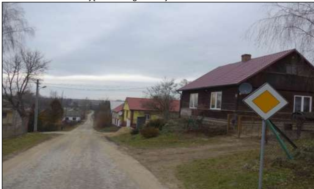
Zdjęcie 13 Droga w miejscowości Tułkowie
